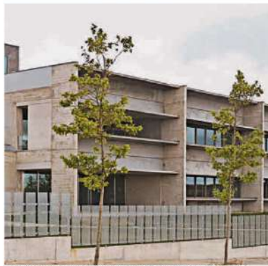
Edificio de Abioinnova, acabado y a falta de equipamiento. ALMEIDA
